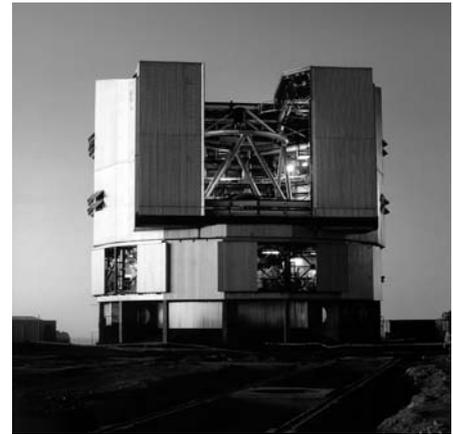
Eine der vier Kuppeln für die 8,2-m-Teleskope des VLT (Very Large Telescope) auf dem Mt. Paranal in den chilenischen Anden. Quelle: ESO
